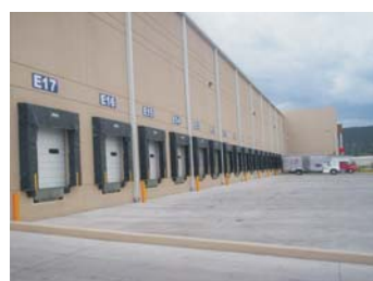
SEÑALIZACIÓN DE ANDENES
